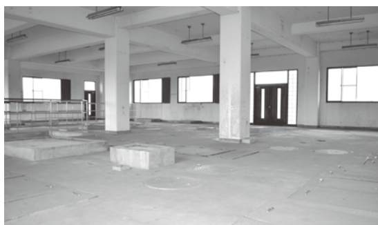
すべての機材が撤去された横田処理場
