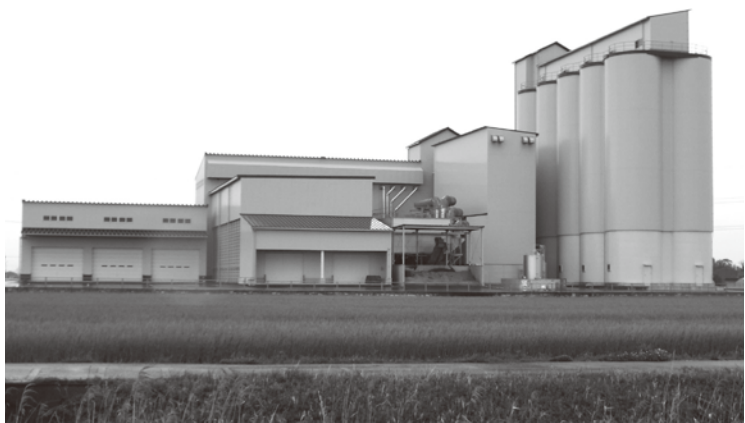
建設が望まれるカントリーエレベータ（みやき町）
