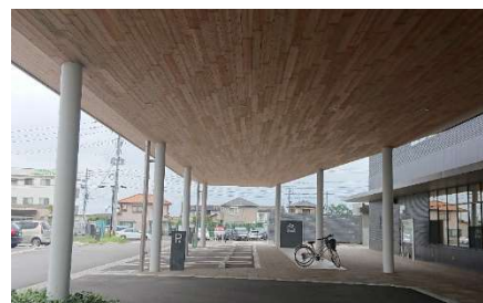
▲ユニバーサルデザインやバリアフリーを取り入れた屋根付き駐車場（神崎市役所）
