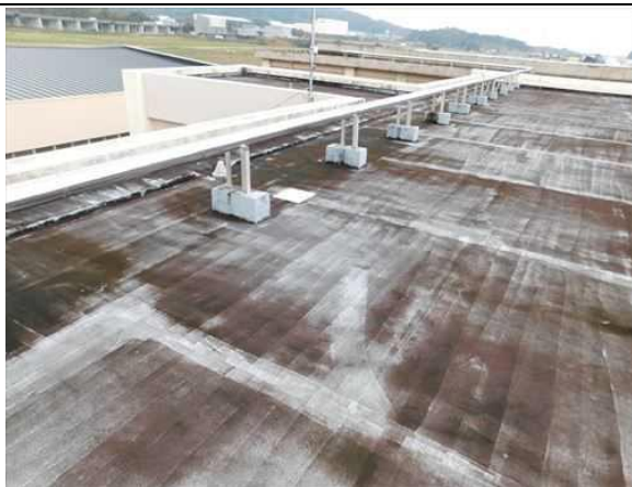
屋上防水：校舎 アスファルト防水の劣化
