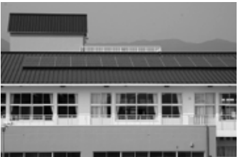
東脊振小学校屋上に設置された「太陽光発電システム」
