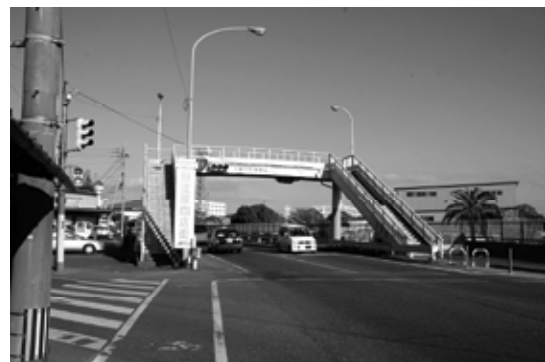
工事が行われる目達原歩道橋
