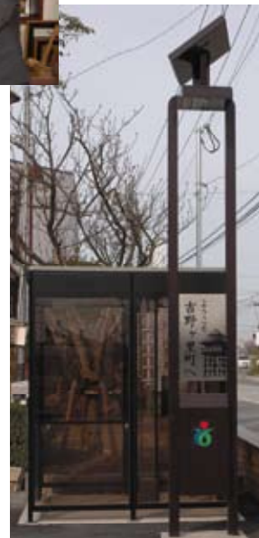
■三田川庁舎前に設置されたLED街灯
