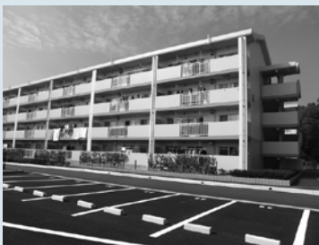
公営住宅建設 (目達原東団地)
