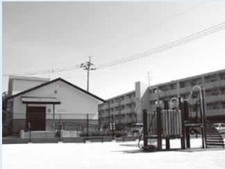
町営住宅目達原東団地と集会所
