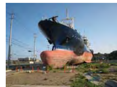
街中に残ったままの大型船(気仙沼市鹿折地区)
