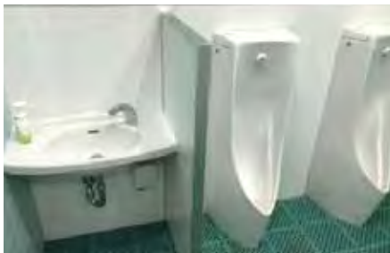
施設内トイレ全面改修
