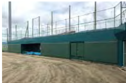
壁面緩衝材改修
