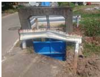
ガードレール及びカーブミラーの破損や損傷
