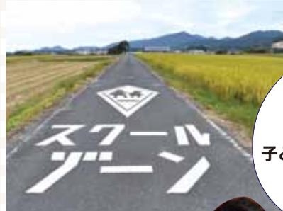
道路を安全に利用していただくため、町道の舗装補修を実施。また、子ども達が安心して通学できるよう、路側帯のカラー塗装や路面標示の新設・復旧を行いました。
