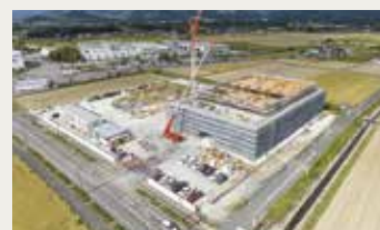
R7.10~12 3・4階躯体工事
