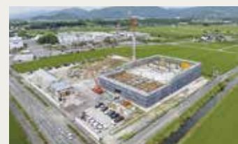
R7.7~9 1・2階躯体工事
