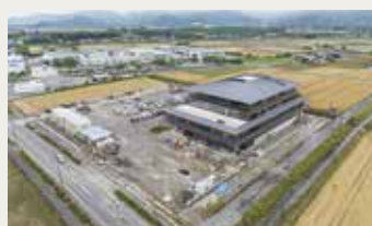
R8.5 足場を撤去
