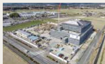
R8.1 屋根・内装工事
